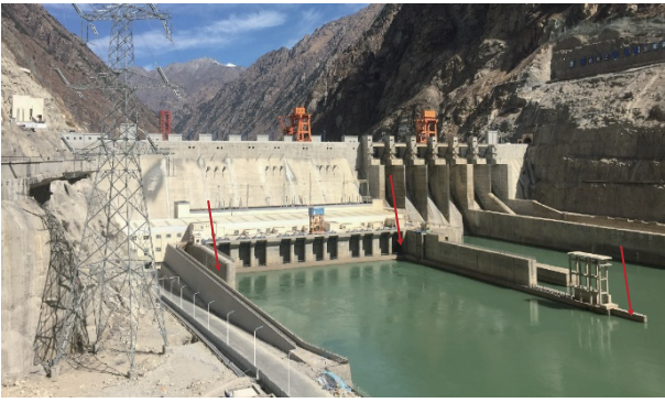
图 1 YJZ水电站坝下(箭头为鱼道进口位置)
