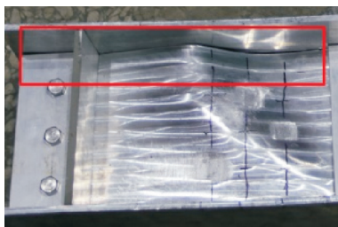
(b) 翼缘板、腹板连接处脆性断裂现象
