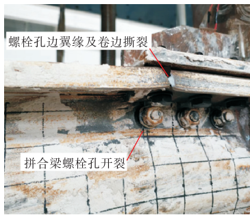
(a) 螺栓孔开裂
