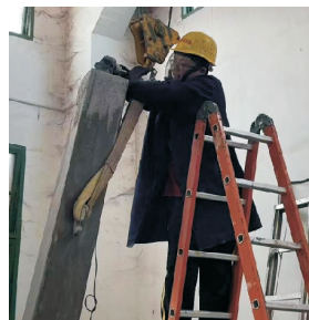
(d) 钢管端部混凝土打磨找平
