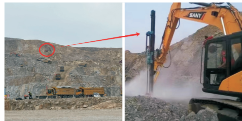
图 3 某工程料场开挖作业
