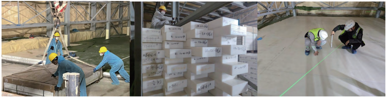
图 16 聚乙烯屏蔽舱板材转运、拼装与检验
