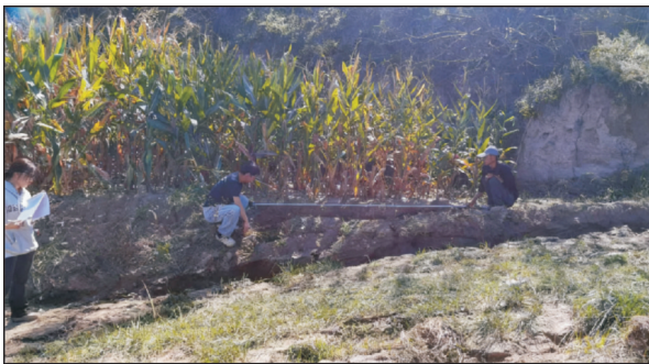
a 道路汇水造成的侵蚀
