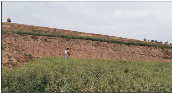
b 1 削坡复式梯田(实景图)
