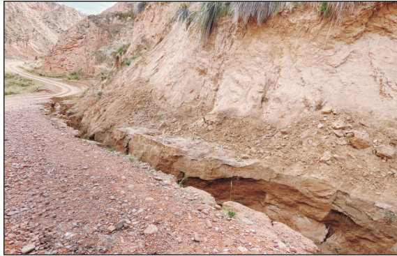
a 严重侵蚀
