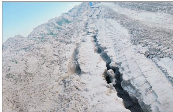
a 坡度为15°道路
