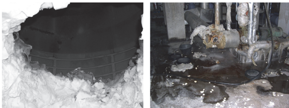
图5 环状二聚体堵塞设备管道示意图
