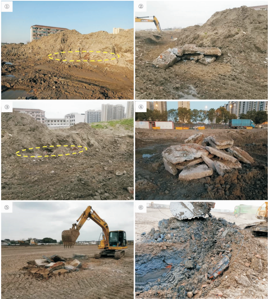
图 13 复垦开挖照片
