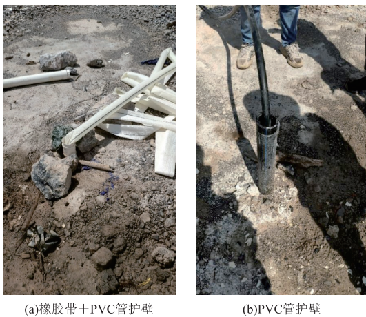
图 6 钻孔护壁措施
