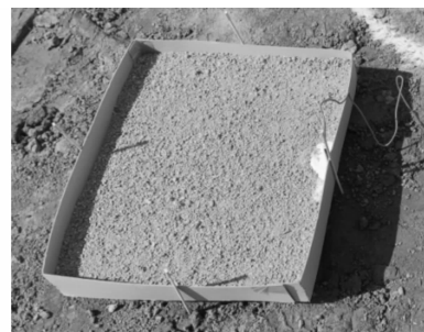
图6 2#试板现场安装图
