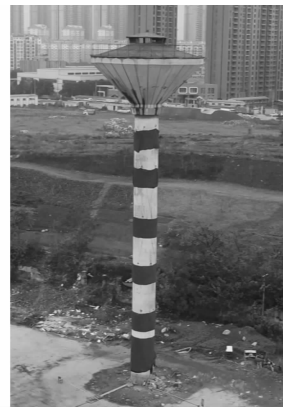
图1 倒锥形钢筋混凝土水塔
