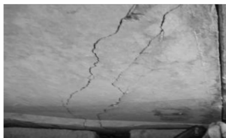
(a) Zone 1 沿纵桥向典型压力线及裂缝分布图
