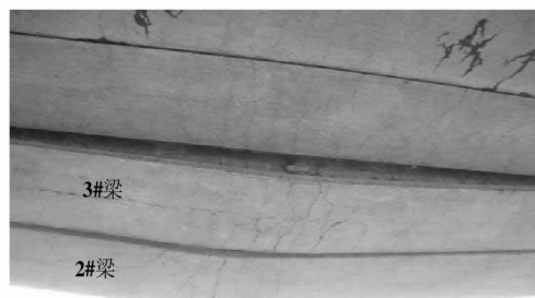
(c) Zone 3 沿纵桥向典型压力线及裂缝分布图
