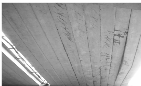
(b) Zone 2 沿纵桥向典型压力线及裂缝分布图
