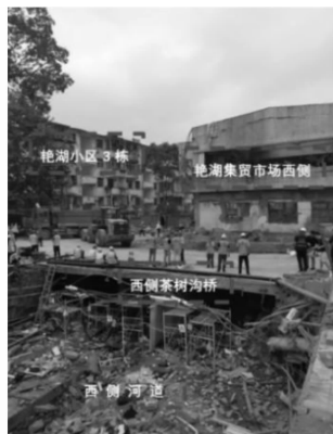
图 4 集贸市场西侧破坏情况
