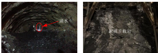
图 1 HD3K0+148 段掌子面现场及围岩
