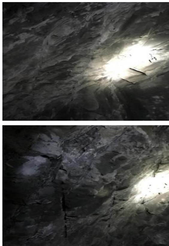
图1 常规光面爆破爆后效果
