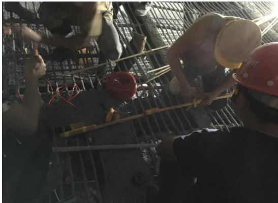
图10 现场装药结构图
