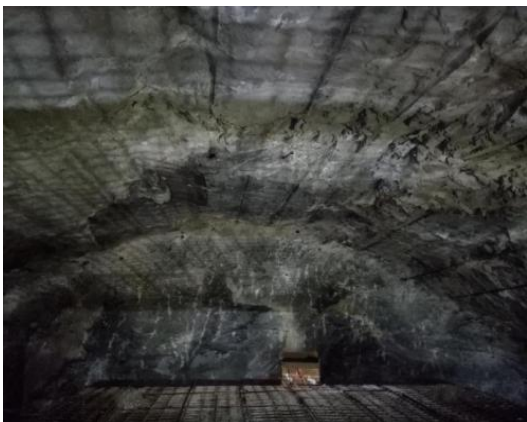
图11 水垫封爆破光面爆破爆后效果
