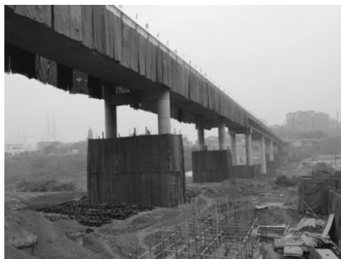
图6 爆破飞石防护措施
