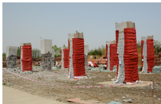
(b) 部分立柱爆破效果
