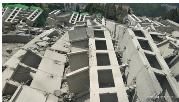
图4 爆破后现场照片
