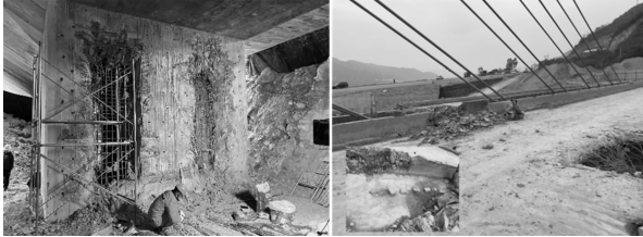
图4 下塔柱及桥面的预处理
