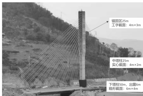
图 2 桥梁结构
