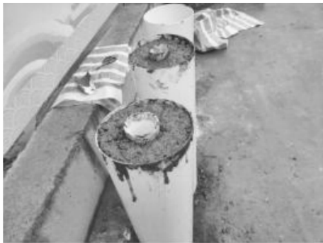
图 11 混凝土浇筑过程图 Fig. 11 Concrete pouring process
