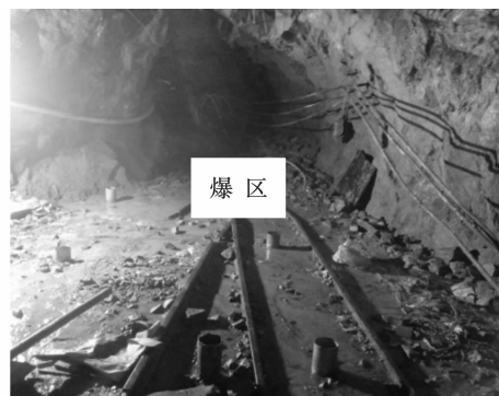
图1 爆破试验探洞
