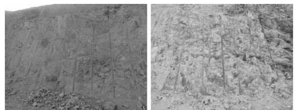
图10 预裂爆破效果图
