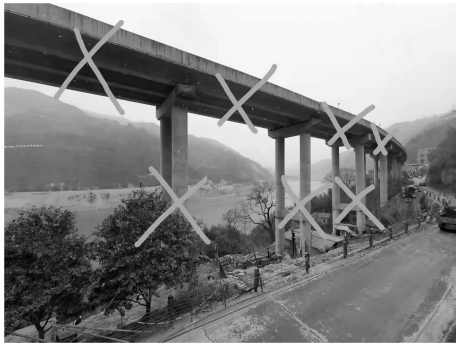
图 1 需爆破拆除部分桥跨实景图
