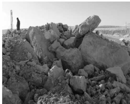
图2 冻土层爆破后大块
