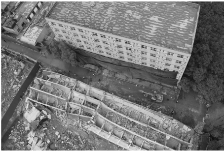
图 11 A13 楼整体爆破效果
