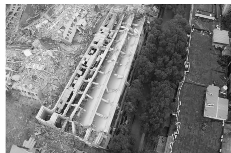
图 9 A3 楼整体爆破效果
