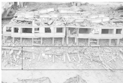
图1 框架结构楼房爆破后坐实例
