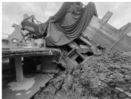
(a) 实际爆堆结果 (a) Actual detonation results
