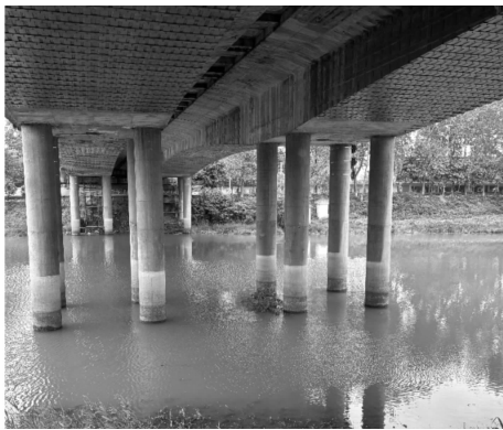
图 4 粘贴钢板加固
