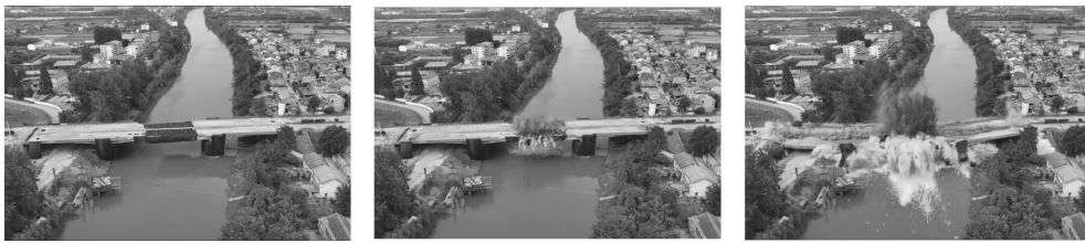
图 13 爆破过程 Fig. 13 Blasting process
