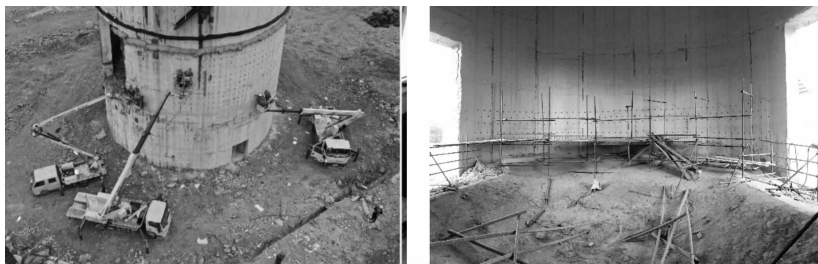
图4 炮孔布置图
