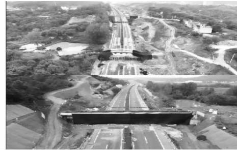
图 9 爆破个别飞散物防护图
