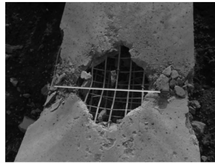
图4 爆炸后钢筋混凝土板破坏情况
