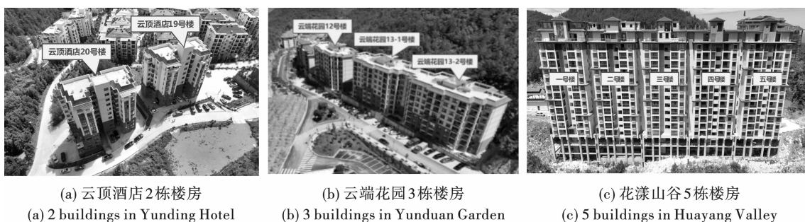
图1 爆破拆除的群楼
