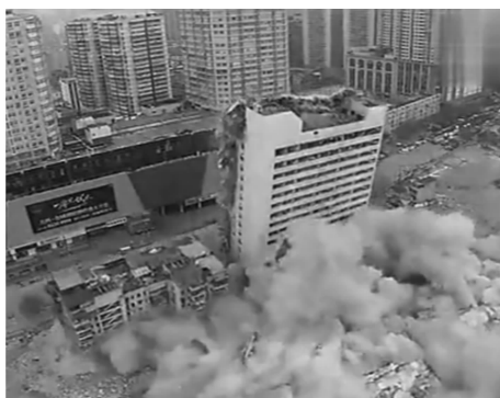
图 4 大楼倒塌过程(倾倒方向)
