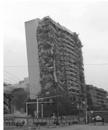
图 7 大楼倒塌过程(倾倒反方向) Fig. 7 Collapse process(opposite collapse direction)
