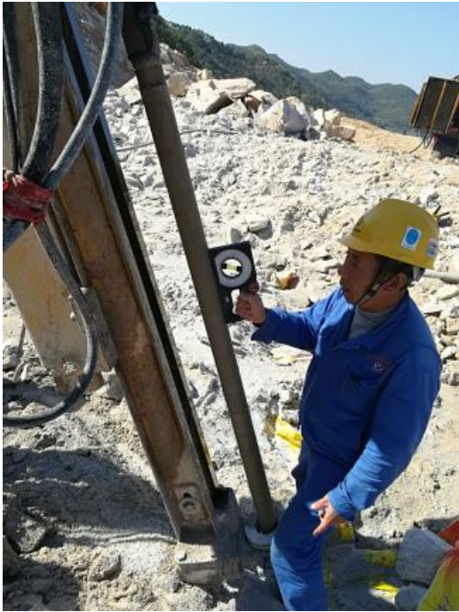
图 5 钻孔角度控制 Fig. 5 Drilling angle control
