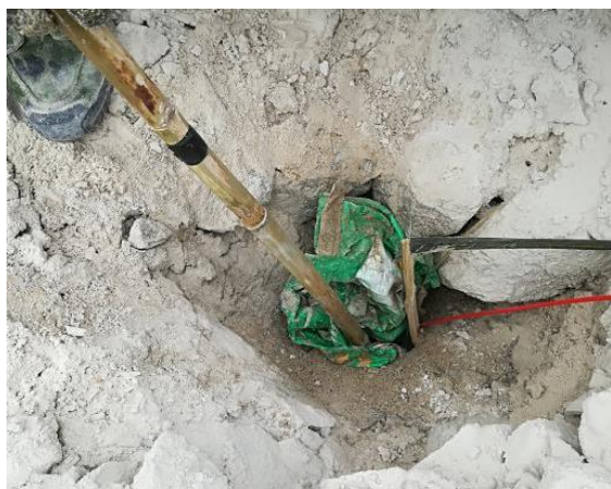
图9 编织袋填塞炮孔
