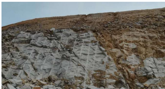
图13 预裂成型边坡面 Fig. 13 Pre-cracked slope
