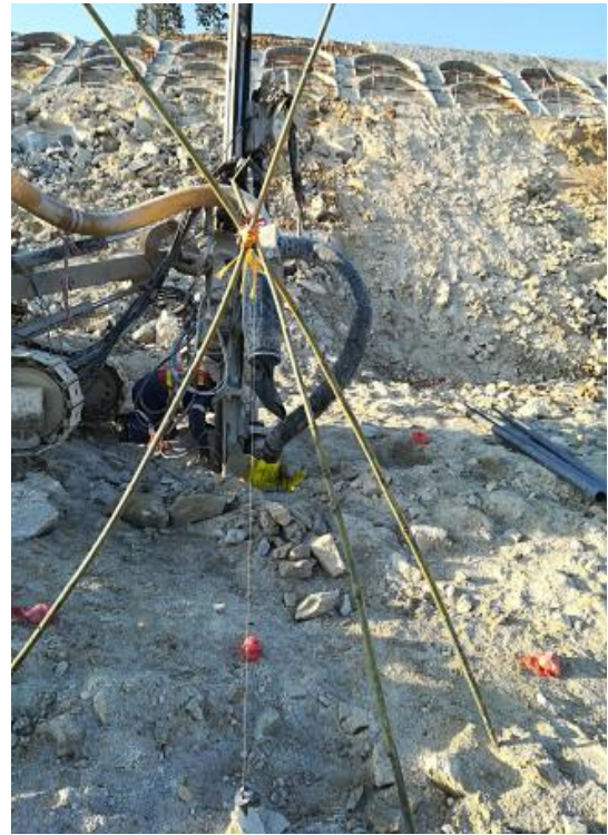
图 6 钻孔方向控制 Fig. 6 Drilling direction control
