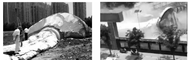
图6 2#水塔二次处理后爆破效果
