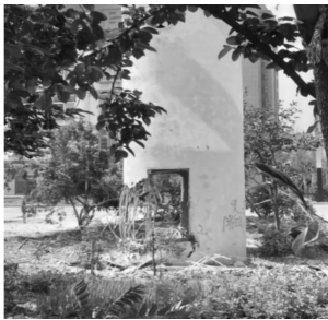
图5 2#水塔第一次起爆后效果
