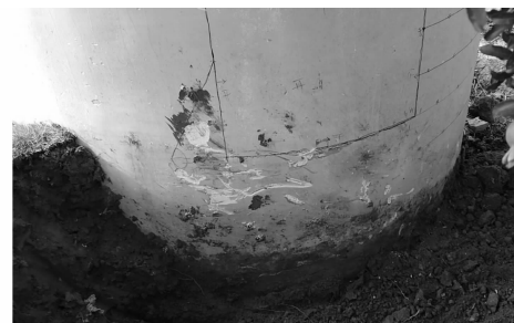
图4 2#水塔定向窗预处理
