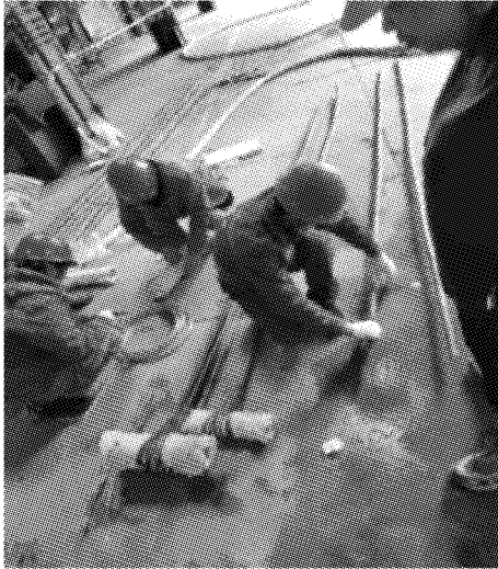
图4 现场药包制作照片
