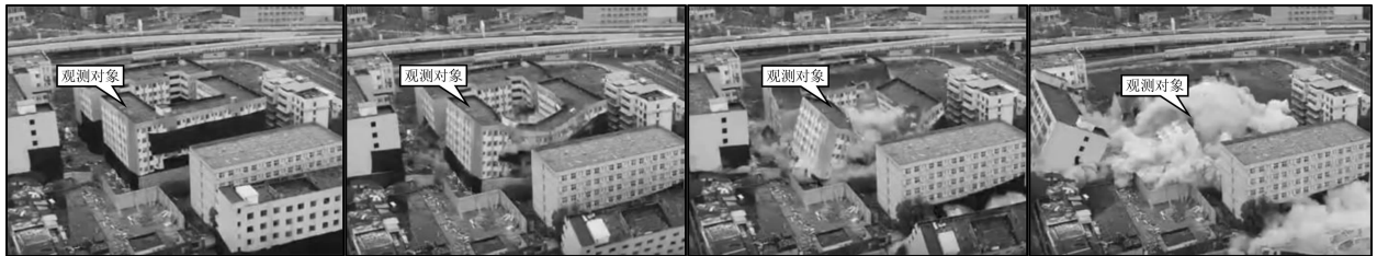
图6 楼房爆破拆除失稳倒塌过程
