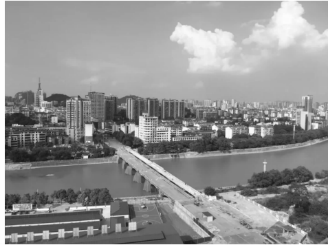
图 8 桥梁安全防护图
