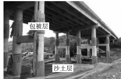
图 11 桥下重点防护措施图
