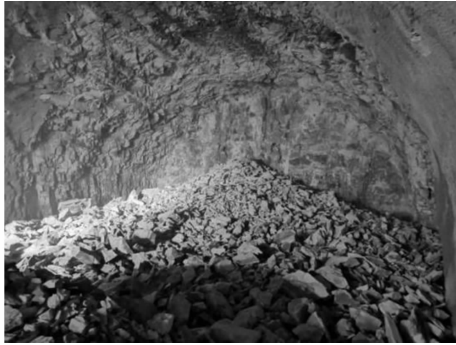
图13 现场爆堆图片
