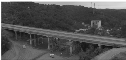
图 2 大桥结构照片
