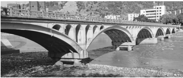
图3 待拆除桥梁实景图
