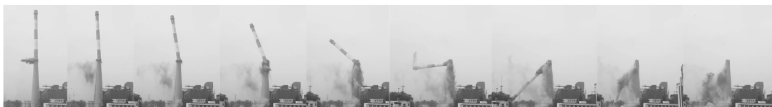
图5 烟囱高位切口爆破倒塌过程
