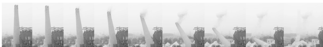
图6 烟囱下部切口爆破倒塌过程
