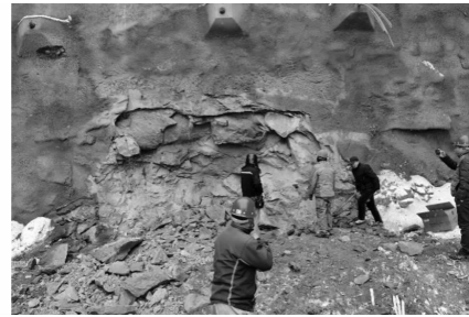
图13 北坡中部欠界掏槽爆破
