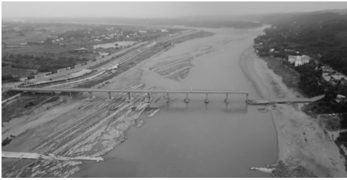
图 1 岷江大桥垮塌后现状
