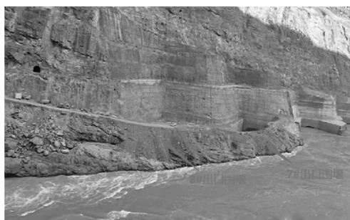
图2 尾水隧洞出口围堰布置图
