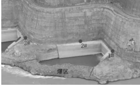
图 10 爆破振动测点布置图
