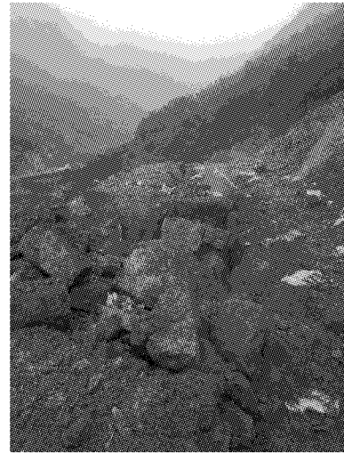
图6 传统预裂爆破成缝效果
