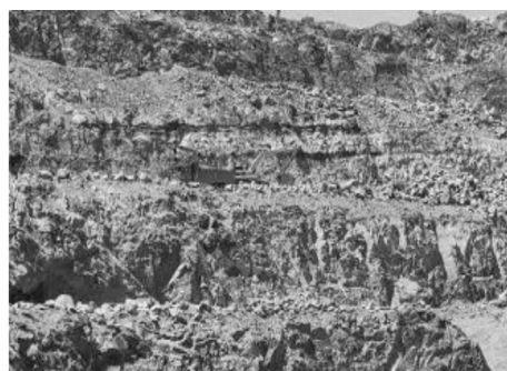
图2 人工和机械清理平台浮石
