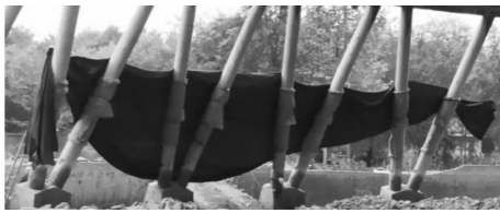
图5 立柱爆破近体防护结构示意图
