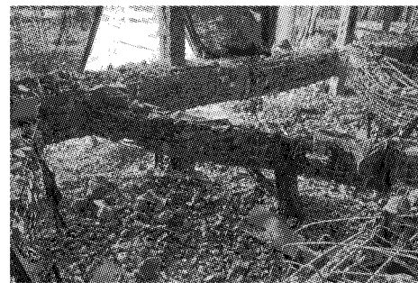
图 12 支撑梁爆破效果
